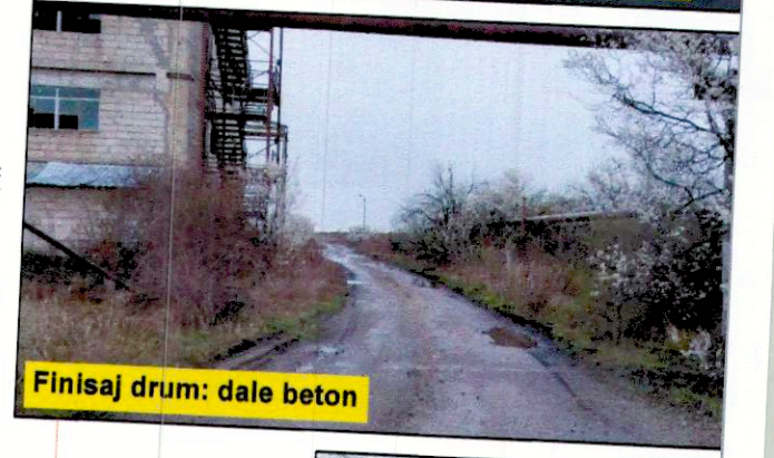
Finisaj drum: dale beton
