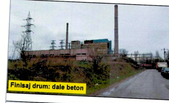
Finisaj drum: dale beton
