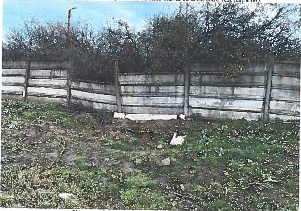
Obturarea și colmatarea brațului cu materiale de umplură
