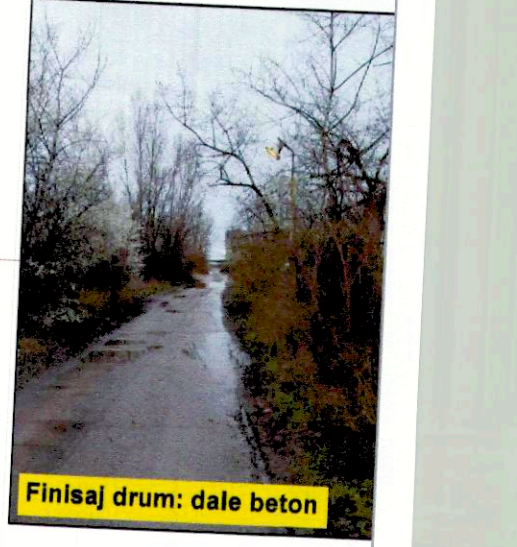
Finisaj drum: dale beton
