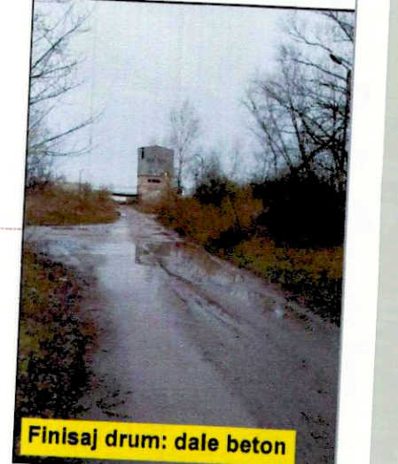
Finisaj drum: dale beton
