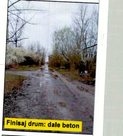
Finisaj drum: dale beton
