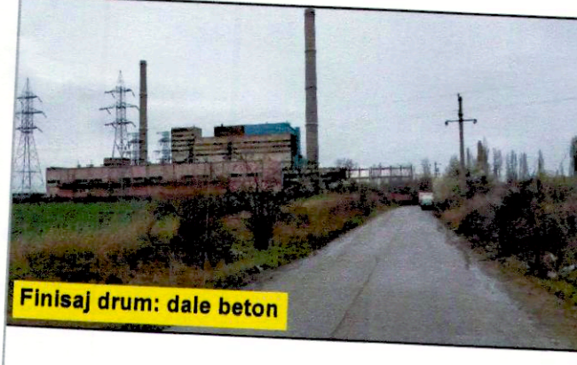
Finisaj drum: dale beton
