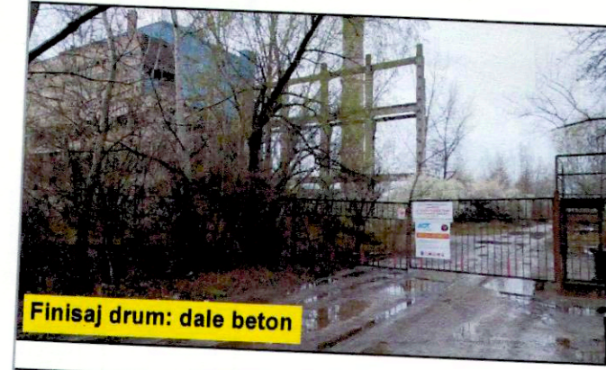
Finisaj drum: dale beton
