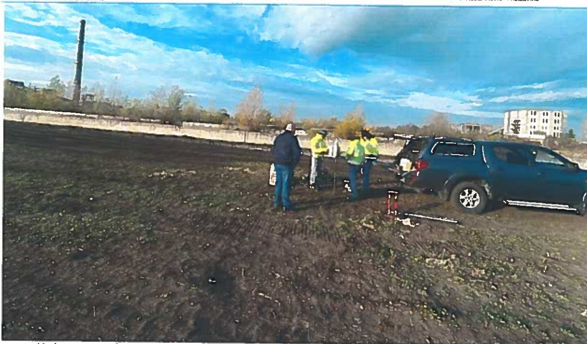
Vedere asupra fostului depozit de cărbune; aspecte din execuția lucrărilor de penetrometrie dinamică
