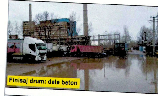
Finisaj drum: dale beton
