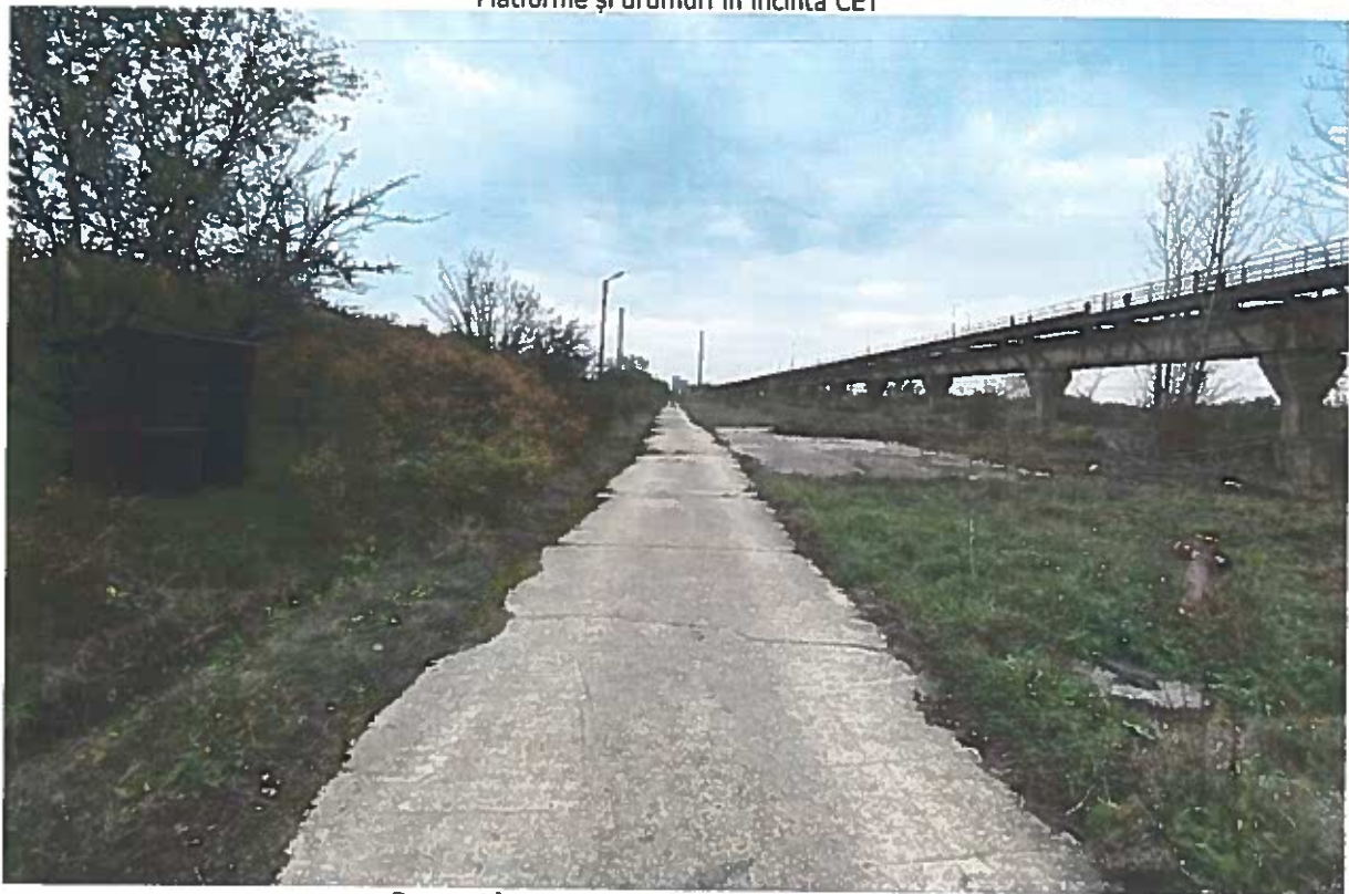
Drumuri în incinta CET; rețele utilități și hidranți
