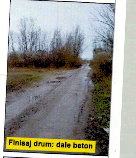
Finisaj drum: dale beton
